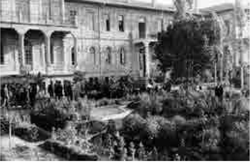
Şekil 8: Çorum Emraz-ı Umumiye Hastanesi cephesi (Şimdiki müze binası) (Çorum Belediyesi Kent Arşivi ve Müzesi)
