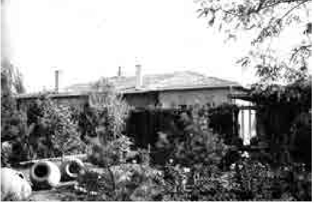
Resim 11: Eski Müze Binası
