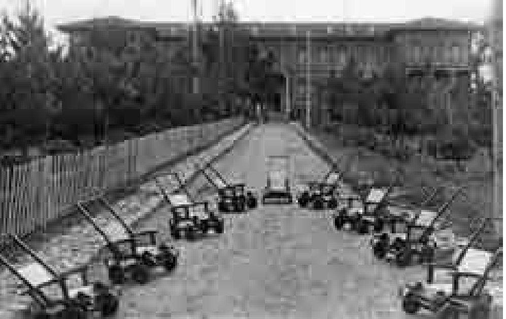
1914 tarihli binanın bahçe kapı girişinden sonra tahta çitle çevrili bahçesi, arnavut kaldırımli tratuarı ve toprak zeminli yola dizilmiş hasta taşıma arabaları görülmektedir.
