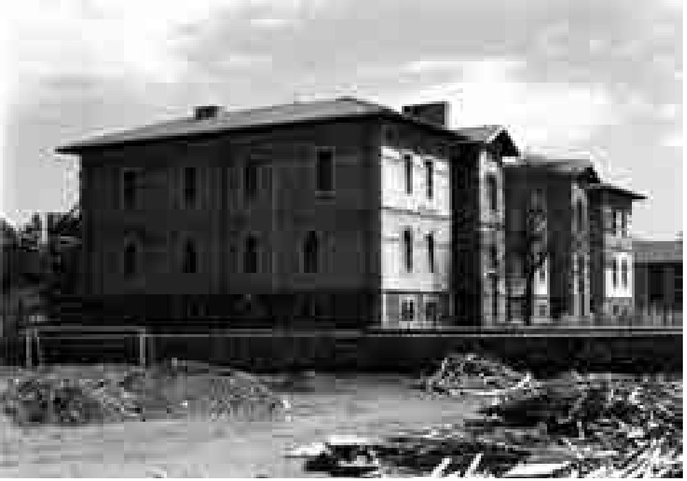
Resim 13: Yeni Müze binasının restorasyon durumu.
